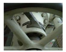
5.1.4 Abrir válvula By-Pass (BP) lentamente verificando el aumento de la presión en la cámara espiral hasta completar su llenado, luego abrir Válvula Mariposa (VM). Terminada la maniobra de llenado de la tubería cerrar la Válvula By-Pass (BP).
