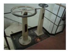
**5.1.5** Abrir el distribuidor en comando manual (mediante palanca MANIOBRA A MANO en posición incluida) girando el volante, cuidando que la turbina se mueva e incremente su rotación en forma moderada hasta llegar a las 600 rpm.
