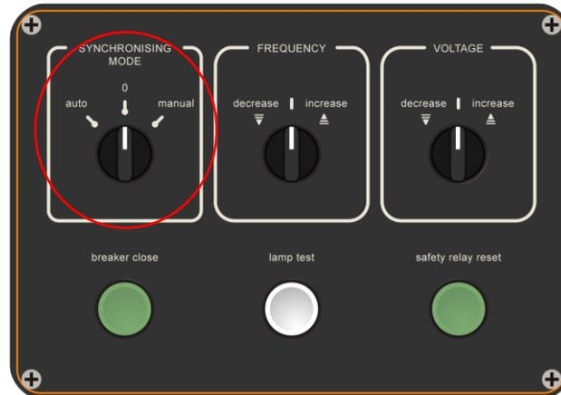
6.5.3. Habilitar el interruptor ubicado en el panel CFA 901 - Energización suave de los transformadores principales AET901-902 (LUP 002-005 Arranque suave)
